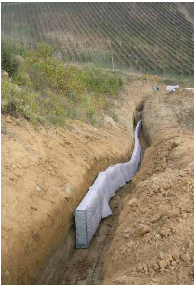
Section drainage in the vineyard - Loc. Boschi di Acqui Terme (AT)
