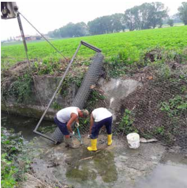
Laying anti-coypus nets in the riverbed - Castell'Arquato (PC)
